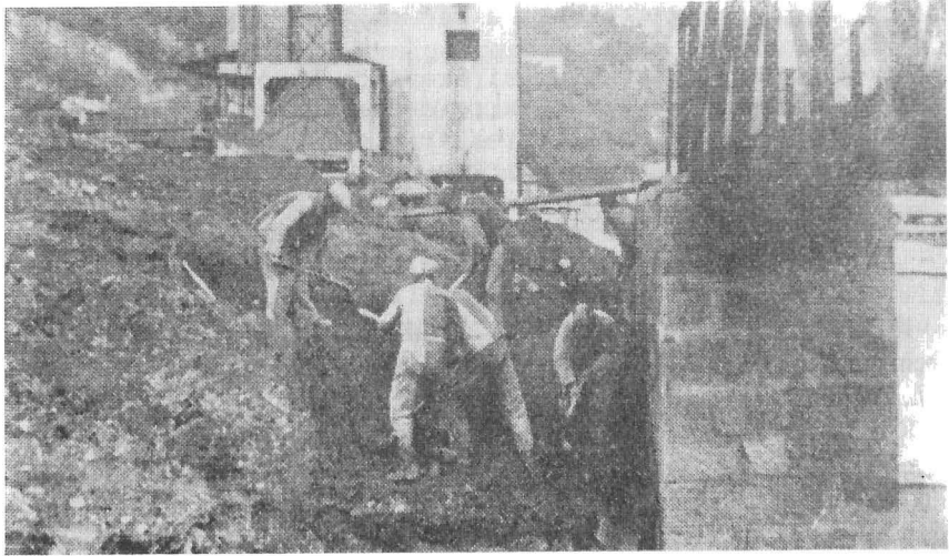
1937-38 Döneminde Harici İşlere Tertip Edilen Mahkûmlardan Bir Takım Üzülmez Sömikok Fabrikasının Müstemilat İnşaatında Çalışıyor (Geri Planda Görülen Baca ve Diğer Tesislerin Kalıntıları Bugün Hâlâ Yerinde Durmaktadır) (8)
