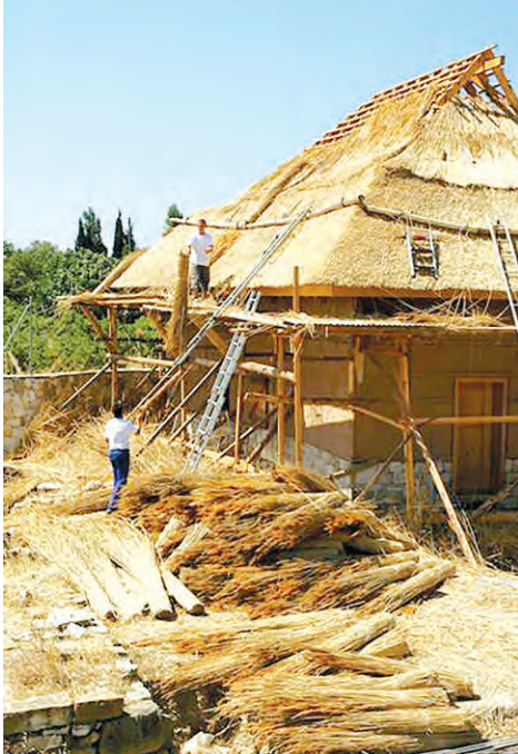
Baba oğlu Barfuss ustalar çatıyı kamış ile örüyorlar.
