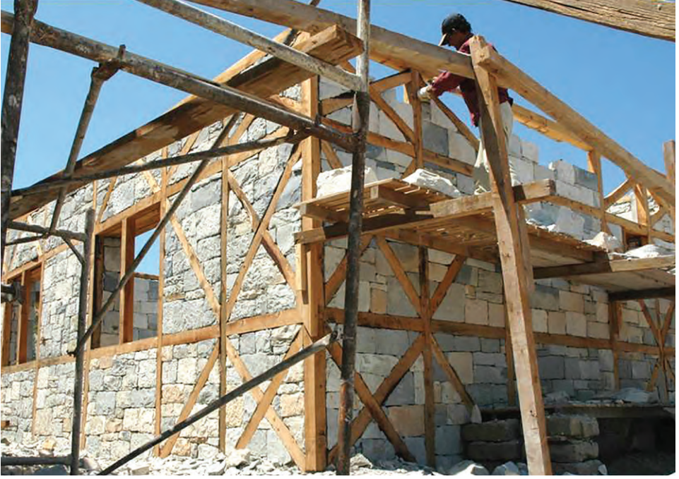
Ahşap karkaslı taş depo binasında restarasyon çalışmaları.
