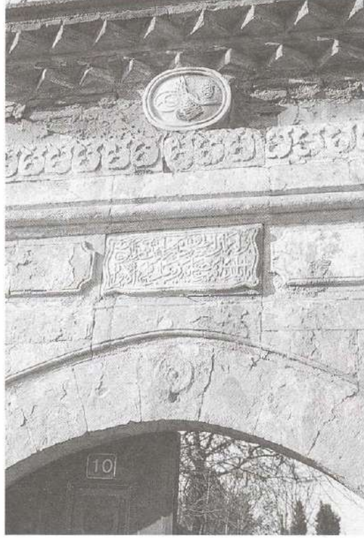
84. Gebze Çoban Mustafa Paşa Külliyesi güney dış avlu kapısı üzerinde farklı dönem onarımlarını belgeleyen yazıtlar
