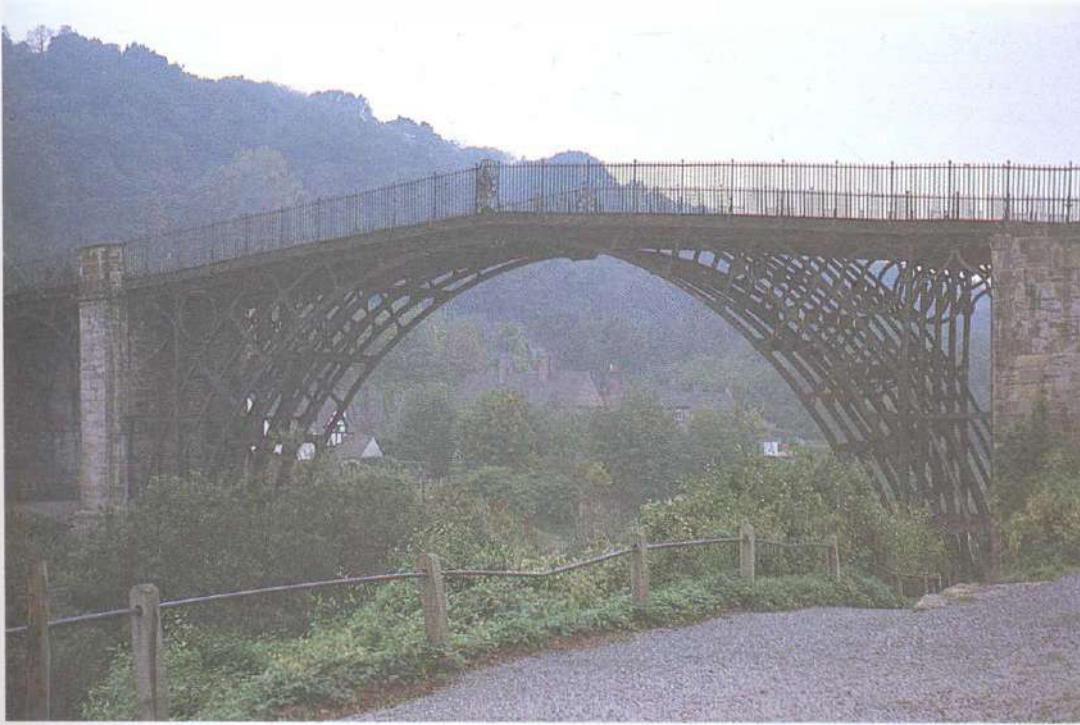
Şekil 18. Severn Nehri üzerinde A.Darby tarafından 1775-79 yılları arasında yapılan 30 m. açıklığındaki ilk dökme demir köprü
