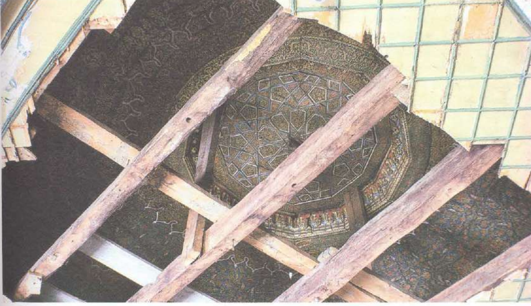
108. Topkapı Sarayı Haremi'nde Veliaht Dairesi restorasyonu sırasında yapılan araştırmalarda çıtalı tavanın kaldırılmasıyla ortaya çıkarılan özgün kubbe (İTÜ Mimarlık Fakültesi, Restorasyon Anabilim Dalı Arşivi)
