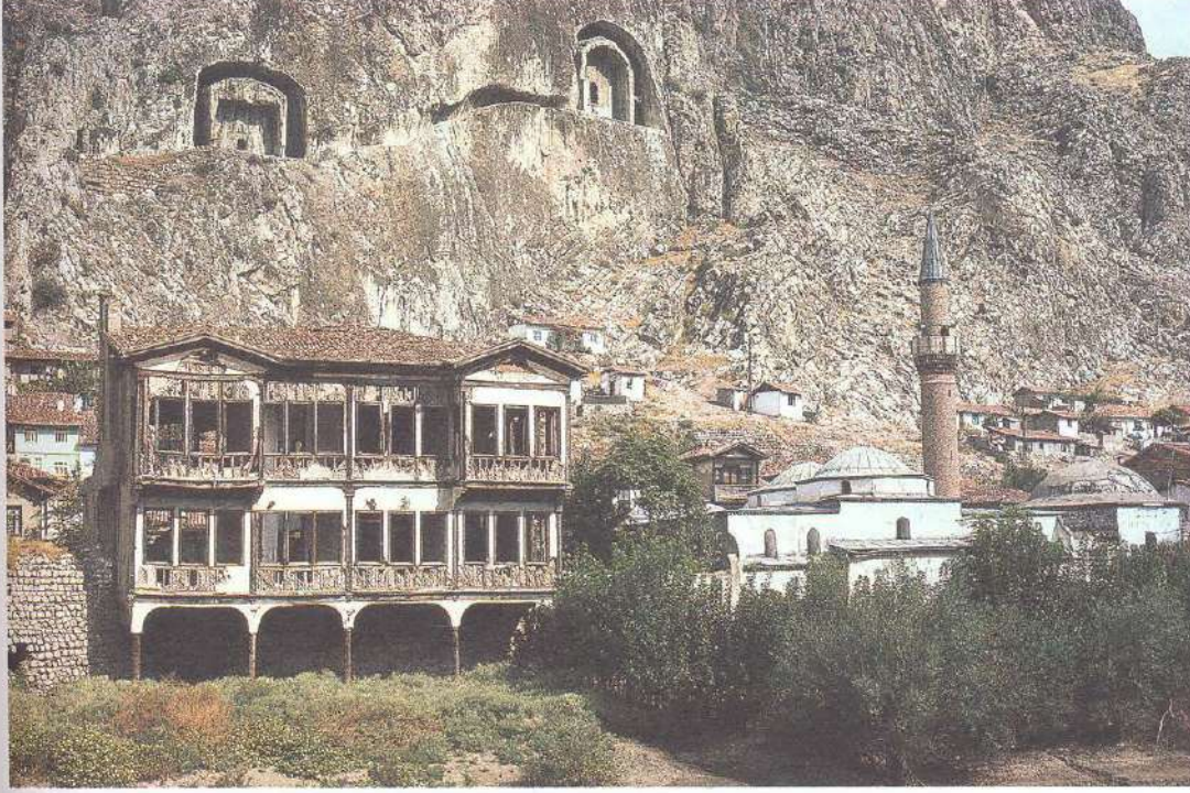
103. Amasya Hazeranlar Konagi'nin onarım öncesi durumu
