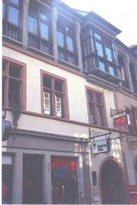
147. Freiburg (Almanya) kentsel sitesi içinde yeni yapı (M. Ahunbay 1989)
