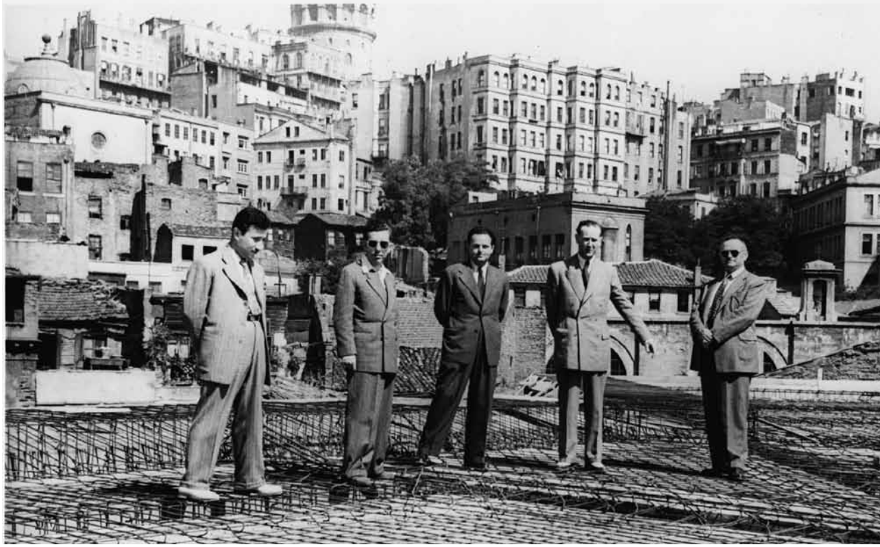
1950'li yıllarda Şişhane'de bir inşaat
