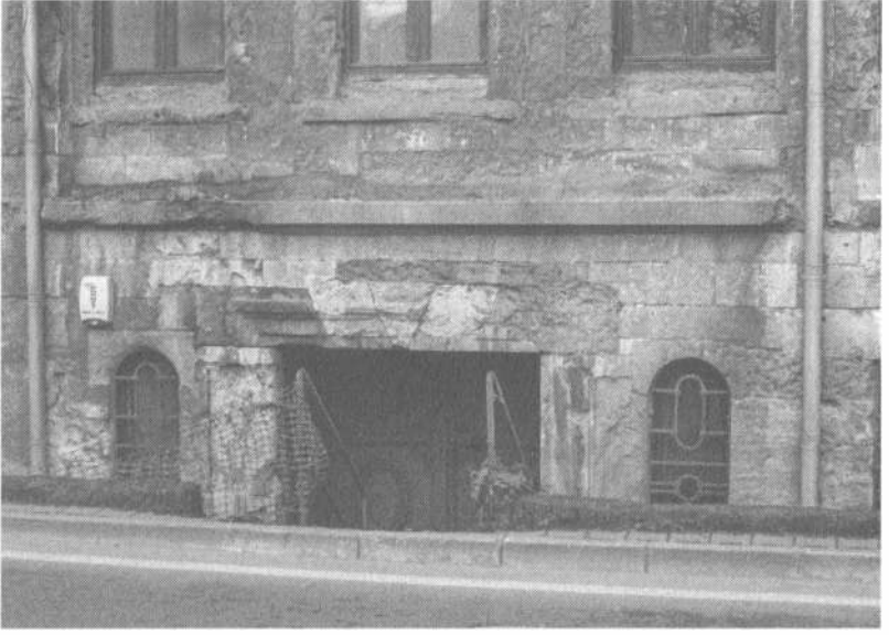
Mürselpaşa Caddesi yol altında kalan Bulgar Eksarlığı giriş kapısı
