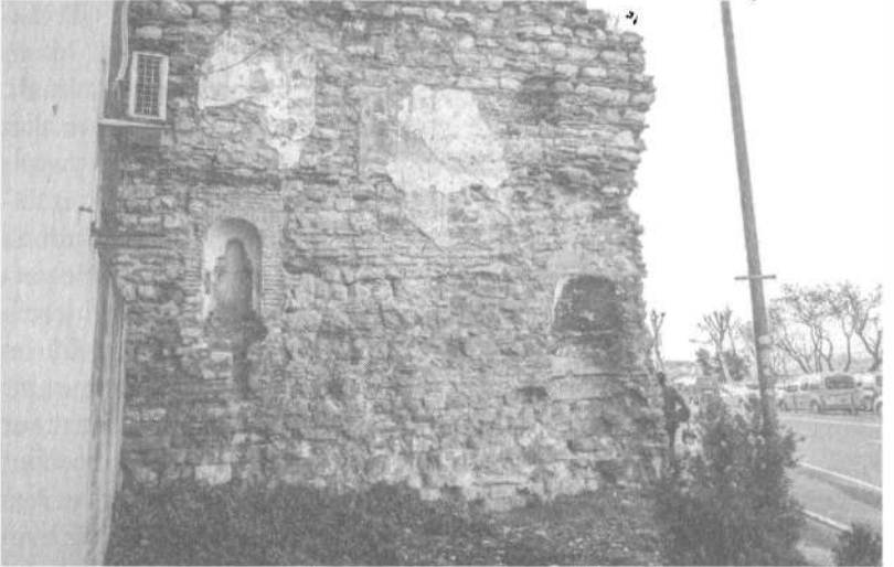
Abdülezelpaşa Caddesi Nevi Kafenin içinde kalan Ayakapı Şapelinin duvarı
