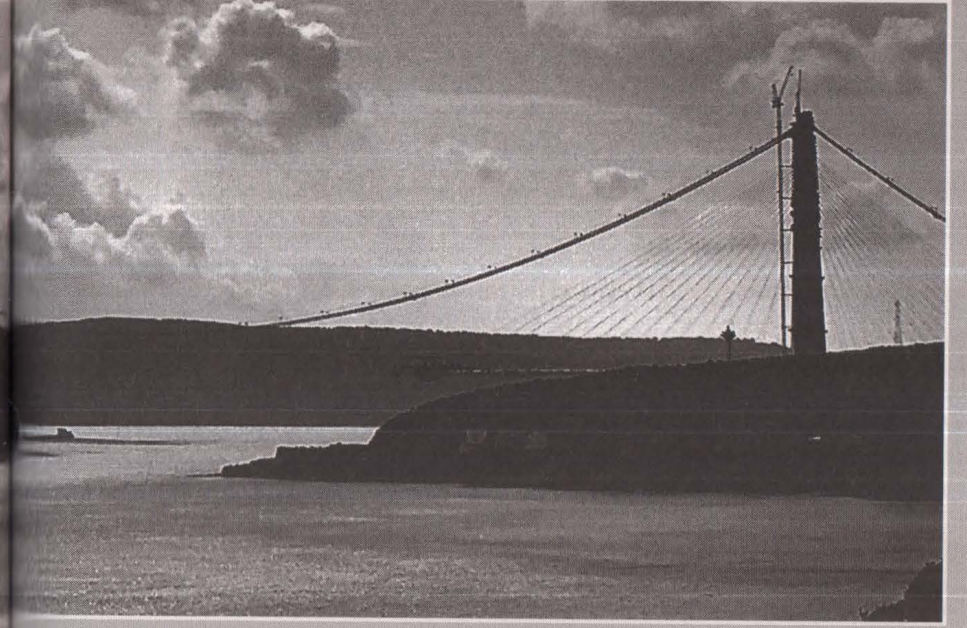
Rumeli Feneri'nden 3. köprü inşaatı manzarası (Fotoğraf: Sinan Logie).
