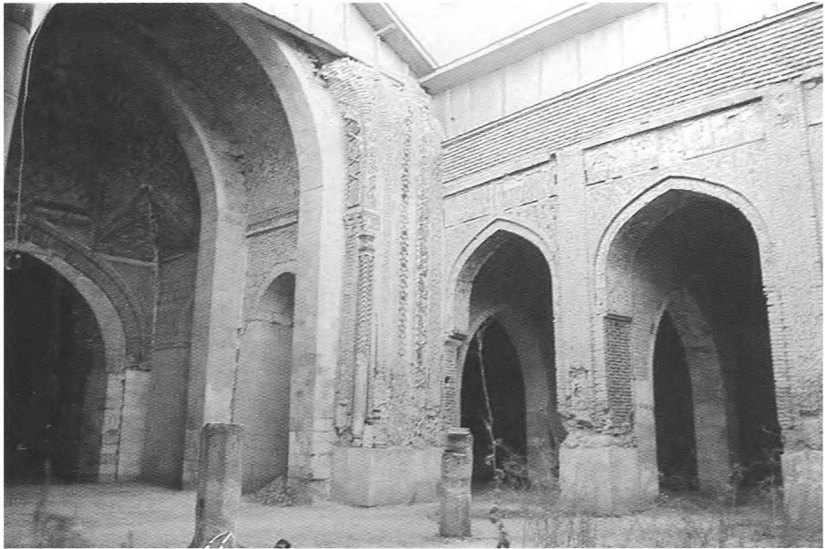
8 - Malatya Ulu Camii, Avludan Görünüş.
