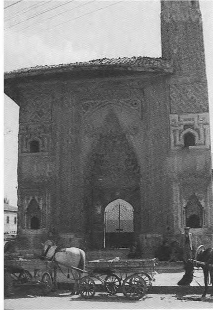
9 - Konya Sahip Ata Külliyesi, Portal.
