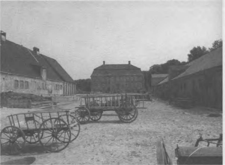
Dassow şehrinin Johannes köyündeki yapı çalışmalarının öncesi ve sonrası.
