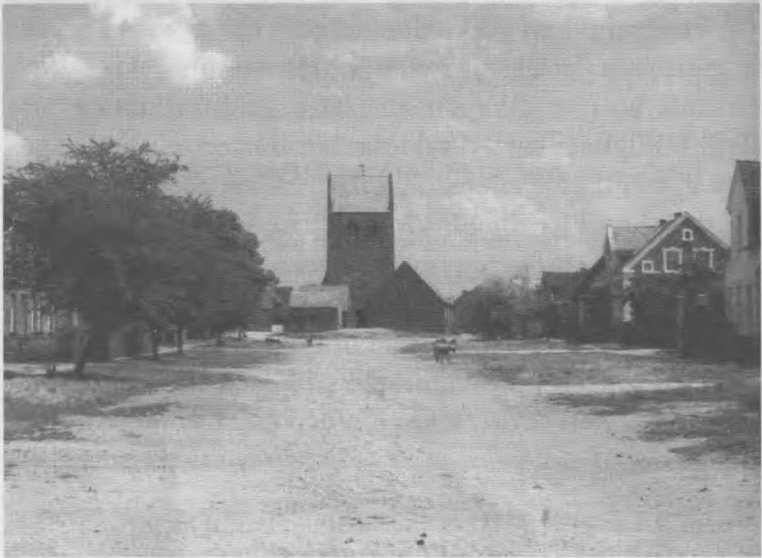
Prignitz'in Netzow köyünde kurulan Beyaz Bant setinin yapı çalışmalarının öncesi ve sonrası.
