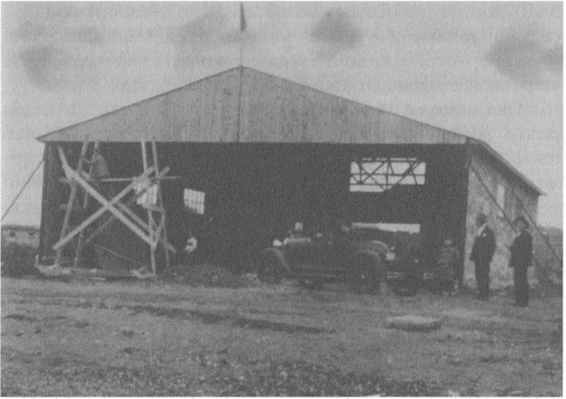
Öğrenciler ve hangar inşaatı.
