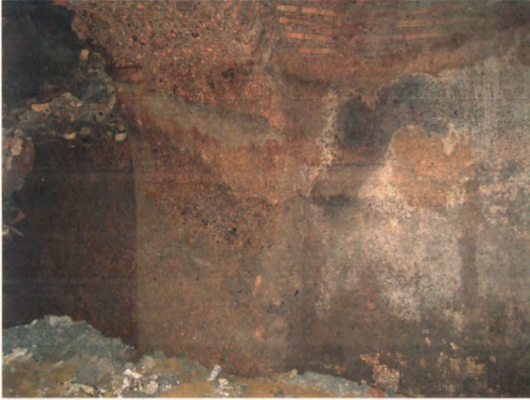
Resim 4: Vidinli Tevfik Paşa Caddesi Sarnıcı'nda hidrolik sıva kalıntısı. (K. Altuğ)
