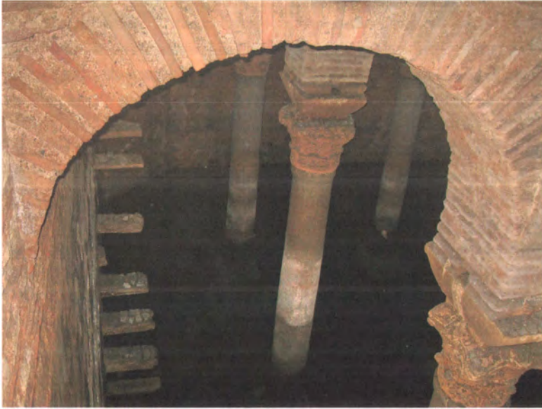
Resim 1: Ahmediye Camisi altındaki sarnıçta (Ortaçeşme-Etmeydanı Sarnıcı) özgün merdivenler. (K. Altuğ)
