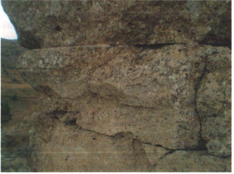
Resim 5: Zenonopolis Kilisesi'nde taşıyıcı ayağın fazlasıyla aşınmış profilli başlığı. (Fotoğraf: T. Saner ve G. Demir)
