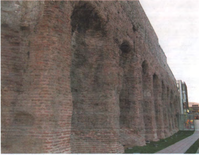
Resim 2: Zeyrek (Pantokrator) Sarnıcı, cephe görünümü. (K. Altuğ)
