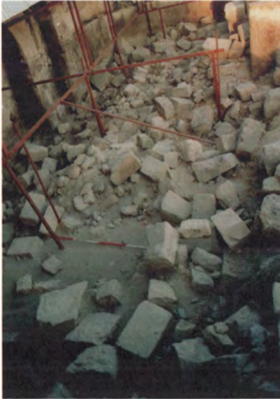
Resim 5: Orta Nef, Zemin, Çöken Tonoz Taşları, 1997
