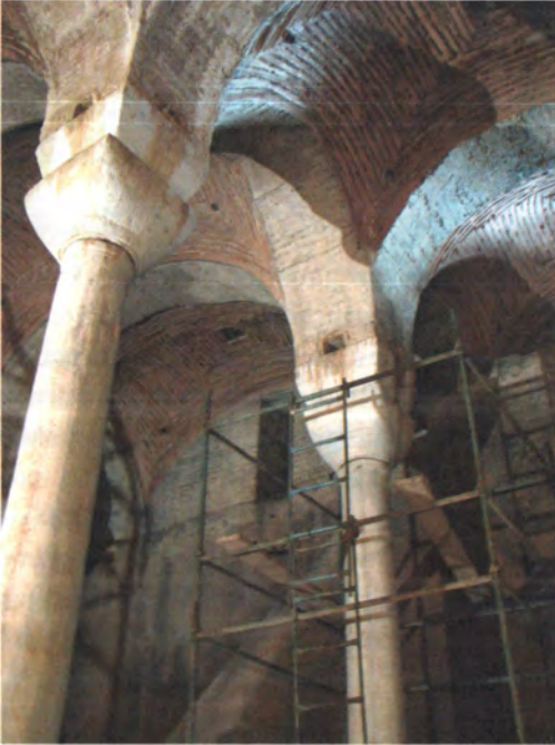
Resim 8: Zeyrek Sarnıcı'nda gergi kirişi yuvalarının görünümü. (K. Altuğ)
