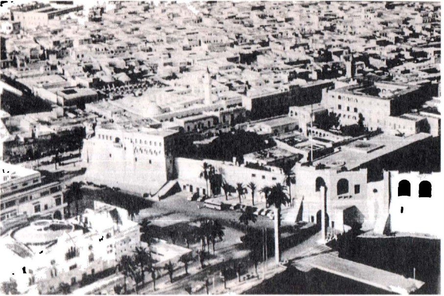
Resim 5. Sol önde Miramare Tiyatrosu ve sigorta binasıyla Kale Meydanı'nın havadan görünüşü.
