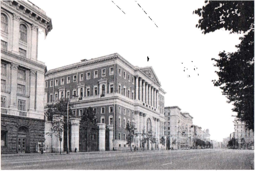
Resim 7. Çeçulin'in yeni bir çehre kazandırdığı Mossovet'in korniş hattı her iki yanındaki apartmanlarıinkiyle tam uyum içindedir. Solda, A. Zhukov'un 1948-50'de inşa ettiği apartmanın alt katındaki koyu granit kaplama, söylentiye göre aslında bir Nazi zafer anıtı için kullanılacaktı. Kuzeye doğru, sokağın Mossovet'in sağındaki bölümü Mordvinov'un 1940'ta inşa ettiği iki yeni-klasik blokla son bulur.
