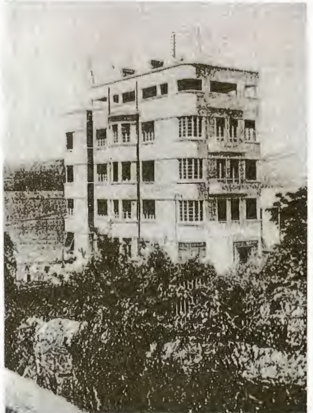
Resim 9- Hasan Nuri Bey Apartmanı, İzmir, 1933-34. Mimar: Necmettin Emre.
