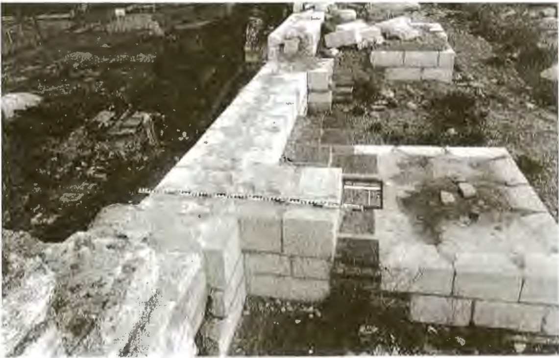
7. Parapet duvarı örgüsünden seğirdim yoluna doğru uzatılmış duvar ayakları.
