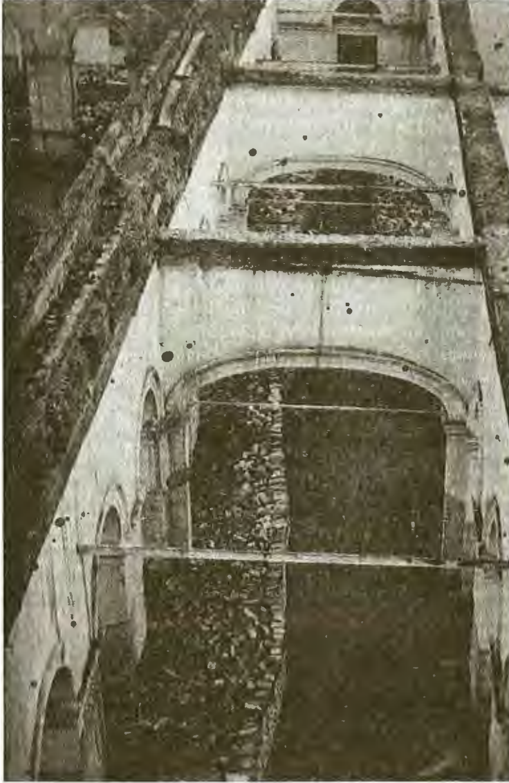
4 - 1945 restorasyonu'ndan bir görüntü. 1894 restorasyonunda değiştirilmiş kemerler.
