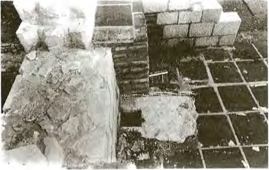
6. T dandanlar arasında, mazgal gerisinde delikli taş blok.
