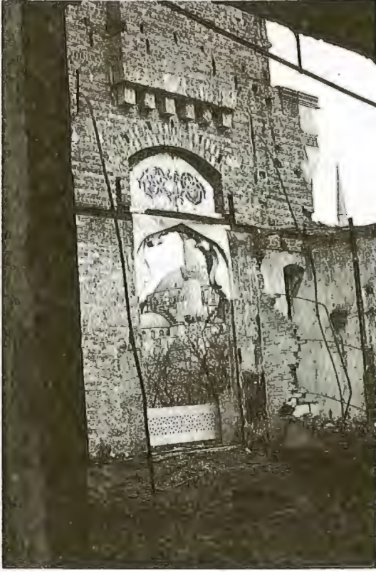
4. Ana binanın 2. kat balkonunun gerisinden ayrıntı: yangın sırasında açığa çıkan demir bağlantı çubukları (1979).
