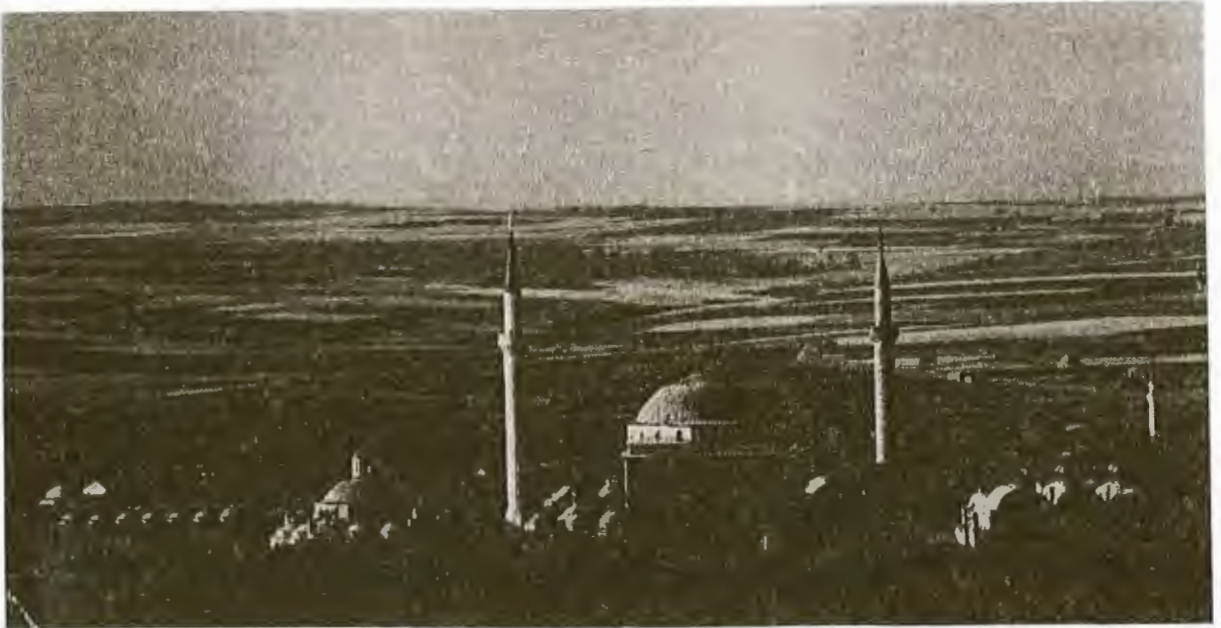
1. II. Bayezid Külliyesi, Edirne. Güneyden görünüş.
