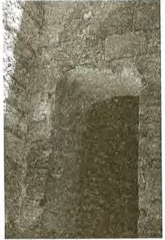
15. Giriş katı: doğu koridorunun kesme taş örgülü güney duvarı üzerinde merdiven izi ve eliptik pencere (C.Birol, M. Pehlivanoglu 1979).
