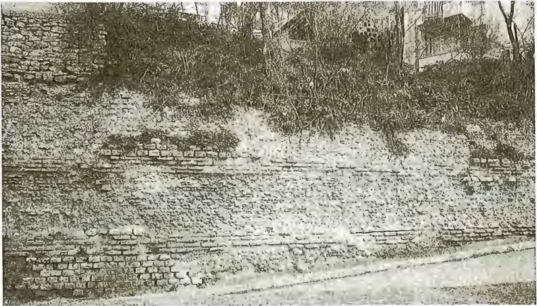
Resim 4. Tuğla/taş almaşık duvar örgüsü.
