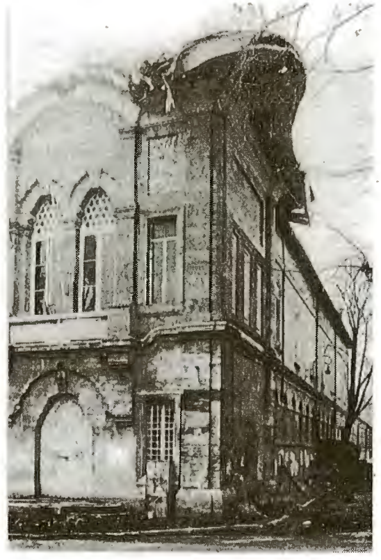
4. Ana binanın 2. kat balkonunun gerisinden ayrıntı: yangın sırasında açığa çıkan demir bağlantı çubukları (1979).
