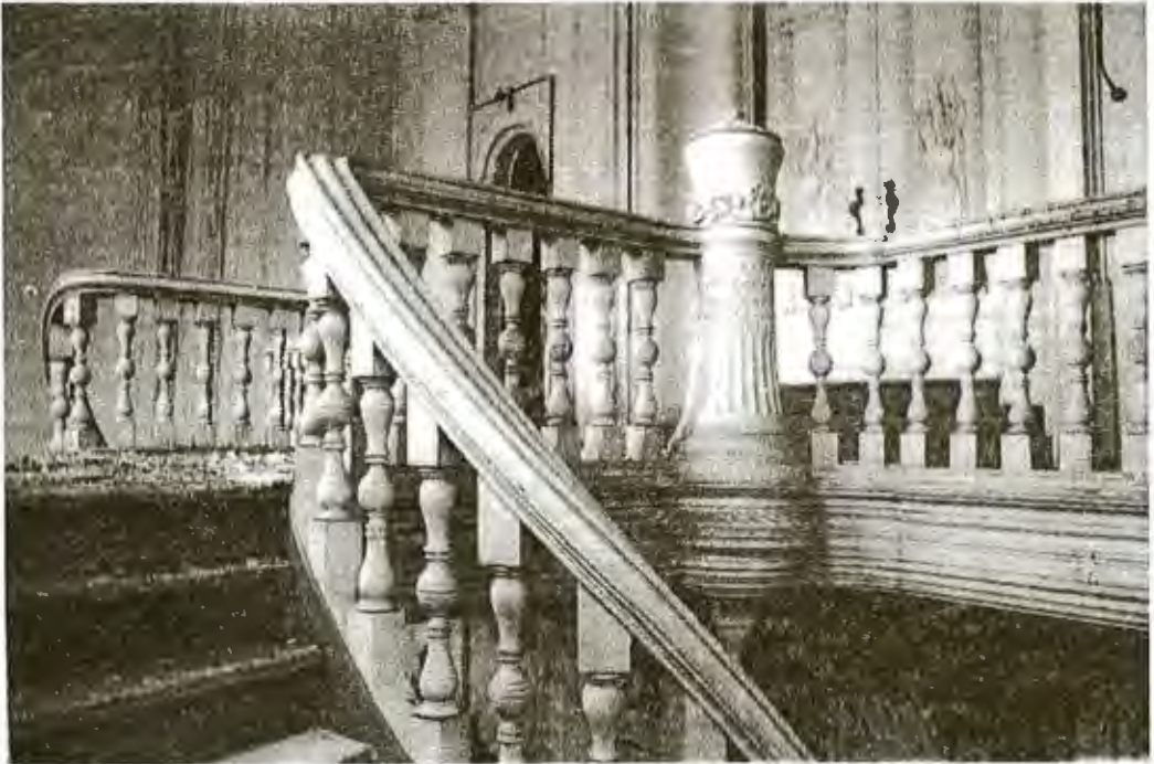
23. Yeniçeri Müzesi merdiven sahanlığının yangın sonrası durumu (İstanbul 1 Numaralı Kültür ve Tabiat Varlıklarını Koruma Kurulu Arşivi, 1978).
