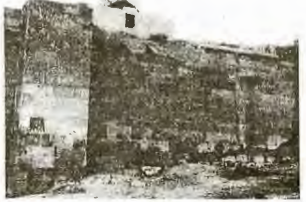
12. Ağzıkara Han çatıdaki odanın penceresi. A. T. Yavuz saydam arşivi, 1989.
