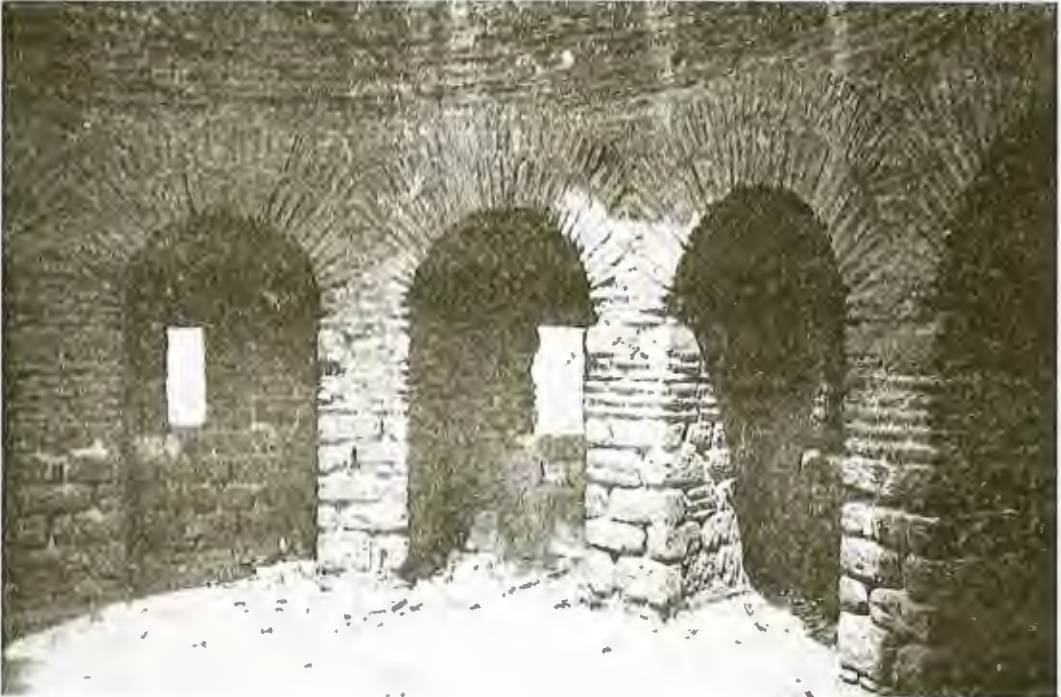
Resim 2. Kemer ve örtüde tuğla kullanımı.
