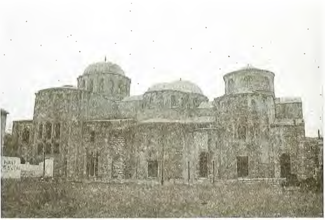
Resim 3. Tuğla duvar örgüsü.
