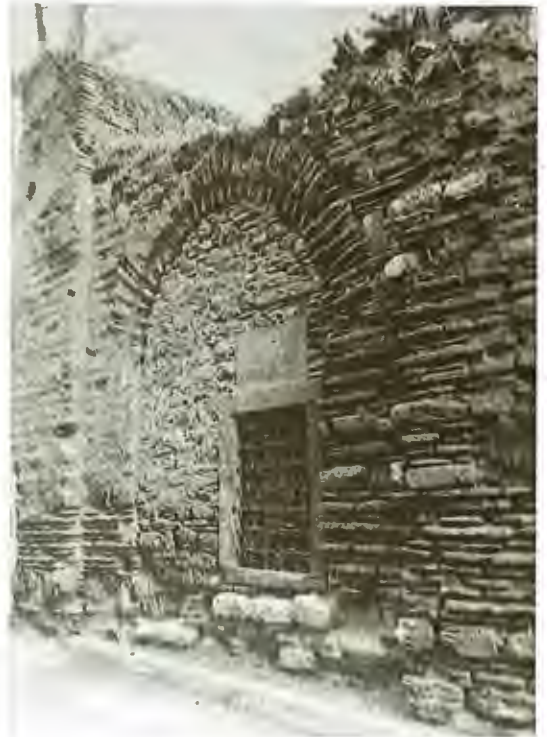
Resim 7. İki farklı boyutta tuğla kullanımı gözlenen "gizli tuğla tekniği".
