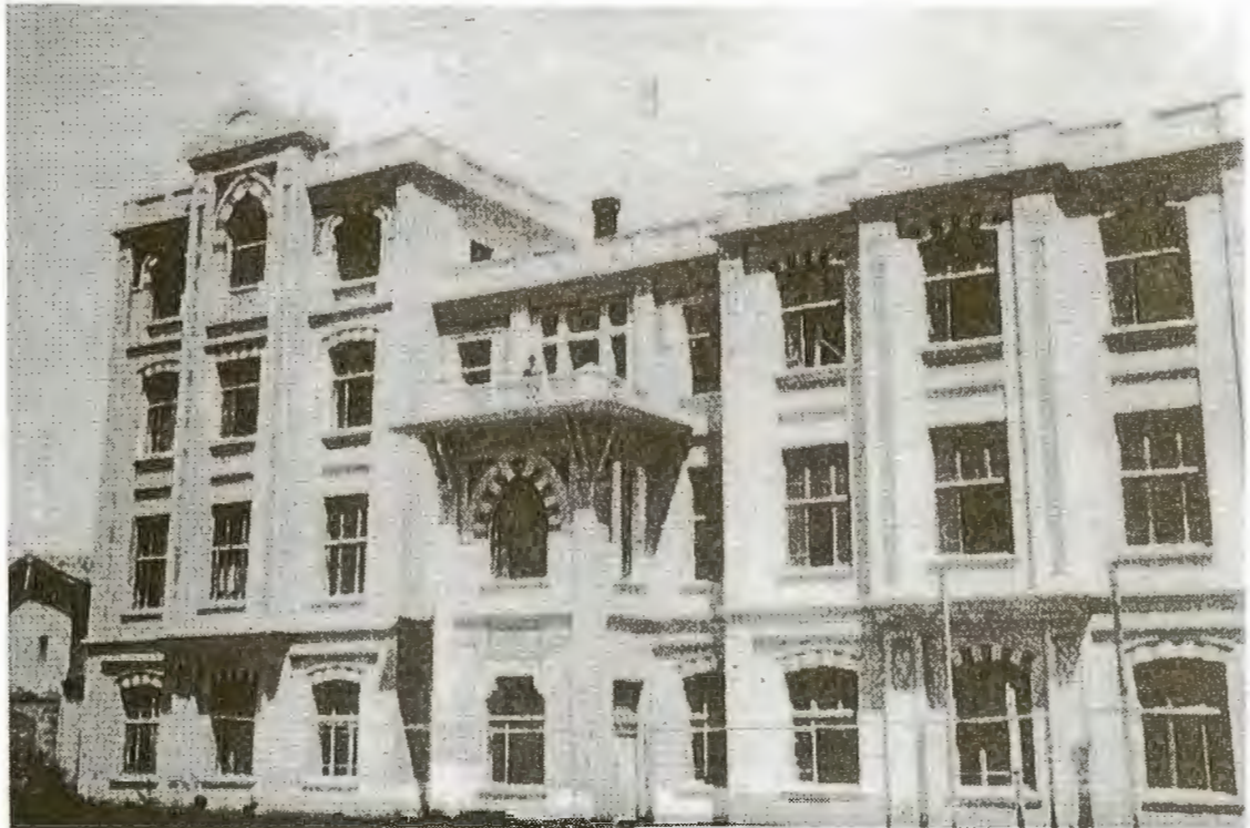
Resim 6- P. T. T. Binası (Büyük Postane), Ankara, 1925, Tasarım: Sodet Firması.
