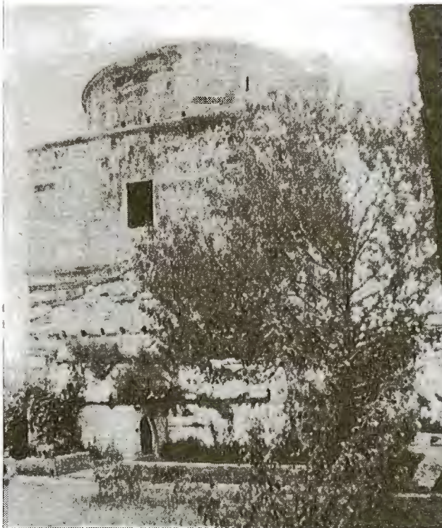
13 - Lüleburgaz'da "Zindanbaba Türbesi" diye bilinen eski ikamet kulesi.
