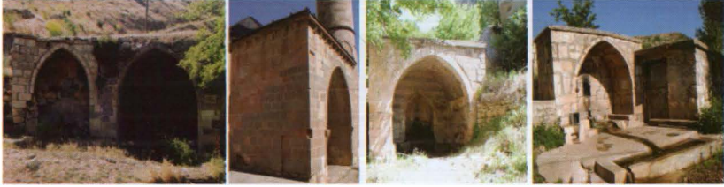
Şekil 12: Yöredeki eyvanlı çeşme örnekleri: a. Pertek-Sağman Külliyesi Çeşmesi, 1555 tarihli. b. Pertek Çelebi Ali Camii Çeşmesi, 1568. c. Ulukale Köyü Meydan Çeşmesi, 16-17. yüzyıl. d. Tunceli-Demirkapı Köyü Çeşmesi.
