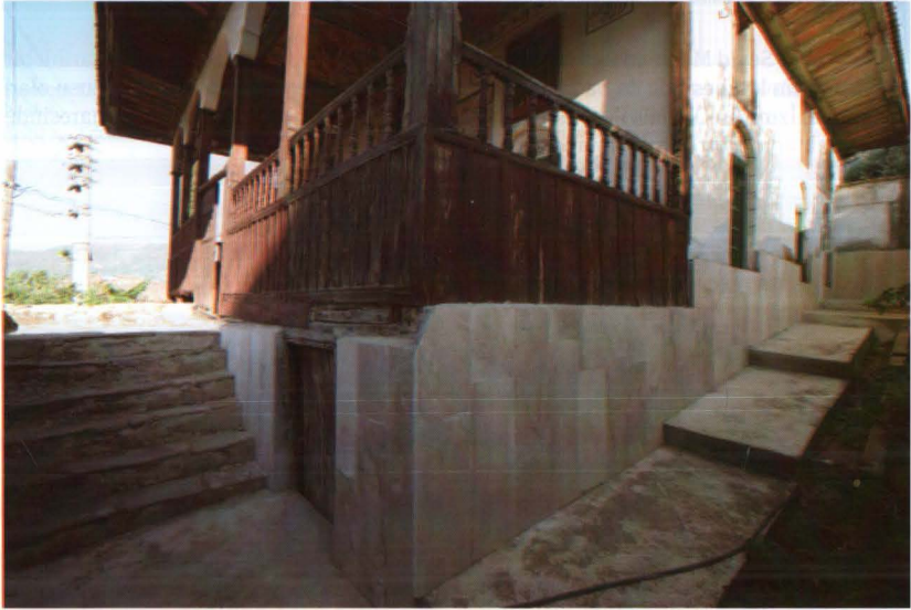
Şekil 29: Kılıczade Mehmed Ağa Camii'nin iç duvarlarında meydana gelen dökmeler.
