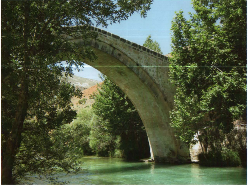
Şekil 13: Çemişgezek Yusuf Ziya Paşa (Tagar) Köprüsü, 1807 tarihli.
