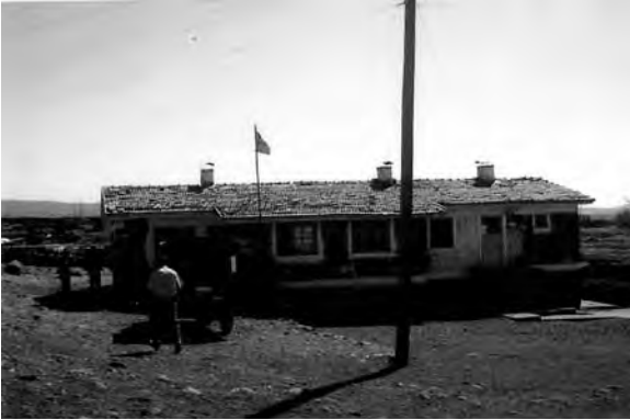
Küftepe okulu onarım öncesi
