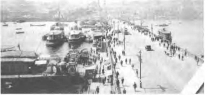
Önceki yıllarda Galata Köprüsü bütün Boğaziçi ve Haliç vapurlarının iskelesi olurdu aynı zamanda.
