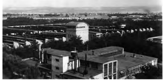
1935 tarihinde açılışı yapılan Sümerbank Kayseri Bez Fabrikası, Sanayi Planlarının sanayi kentleri oluşturma hedefinin ilk örneklerinden birisidir. Sanayi kentlerinin yaratılması düşüncesi, kentlerin sanayi gelişmelerinin sağlanması kadar yeni kent uygulamaları olarak Sanayi Kentleri kurulmasını içermektedir.
