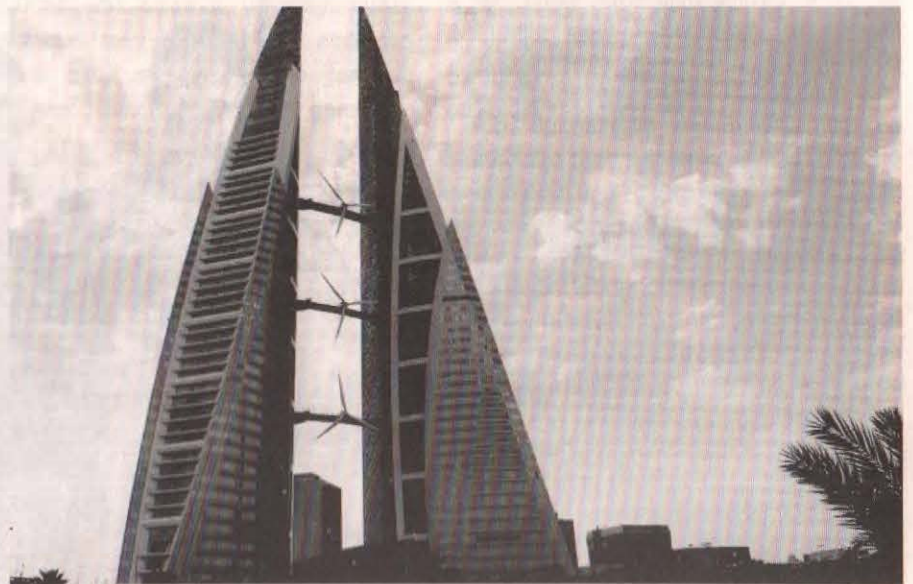
Çin'de rüzgâra uygun düzenlenmiş binalar rüzgârın hızını 1,5'tan 2,5 kata kadar arttırıyor ve bu türbinlerin 15 kat daha fazla enerji üretmesini sağlıyor.
