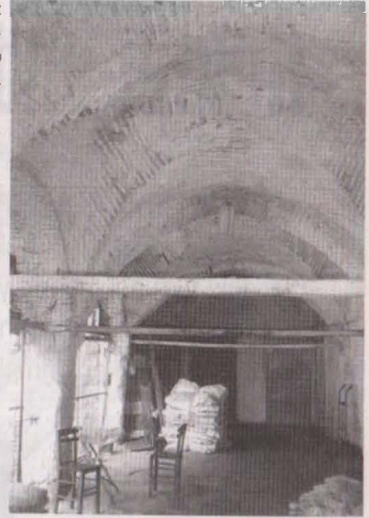
Tahtakale'deki Balkapanı Hanı'nın bodrum ve kısmen zemin kat strüktürü, Venedik ticaret kolonisinden gelen bir fondaco (han) kalıntısı olabilir.
