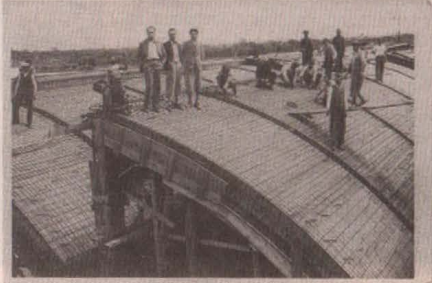
Nazilli Sümerbank Fabrikası inşaatı, 1937.
