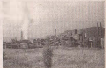
Karabük Demircilik Fabrikası
