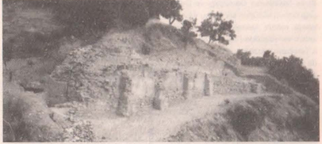
Tralleis Antik Kenti'nde deprem tahribatını en iyi anlatan görüntü. Geç Antik Çağ'da ne zaman gerçekleştiği tespit edilemeyen bir depremle sur duvarı kuzey-güney doğrultusunda yarılmış ve batı yönünde çökmüştür.
