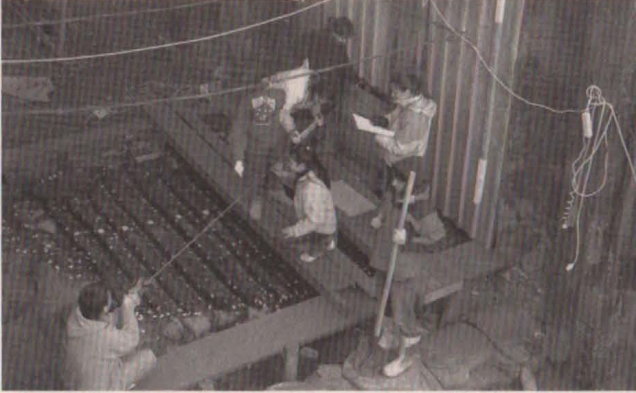
Yenikapı Bizans batıklarının kurtarma çalışmaları.
