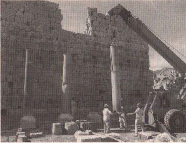
Perge'de sütunları ayağa kaldırma çalışmaları.
