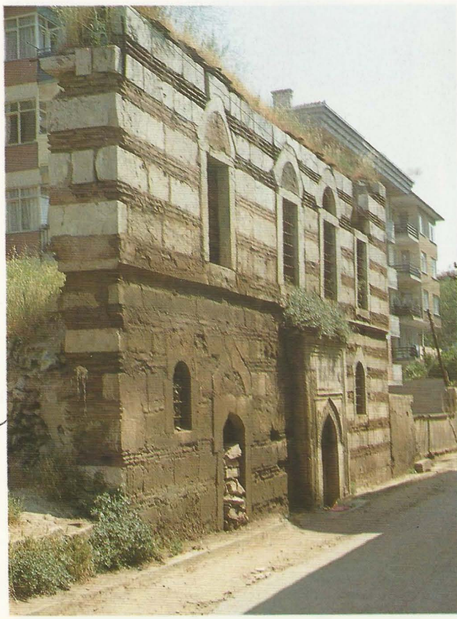
Taşmektehin duvarı ve çeşmesi
