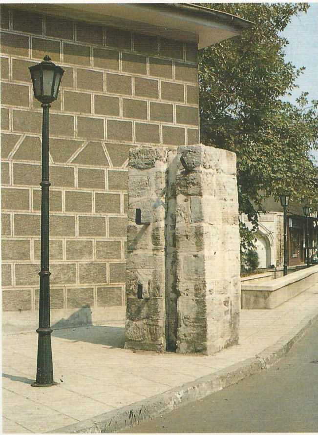
İmrahor Camii önündeki 83 nolu su terazisi
