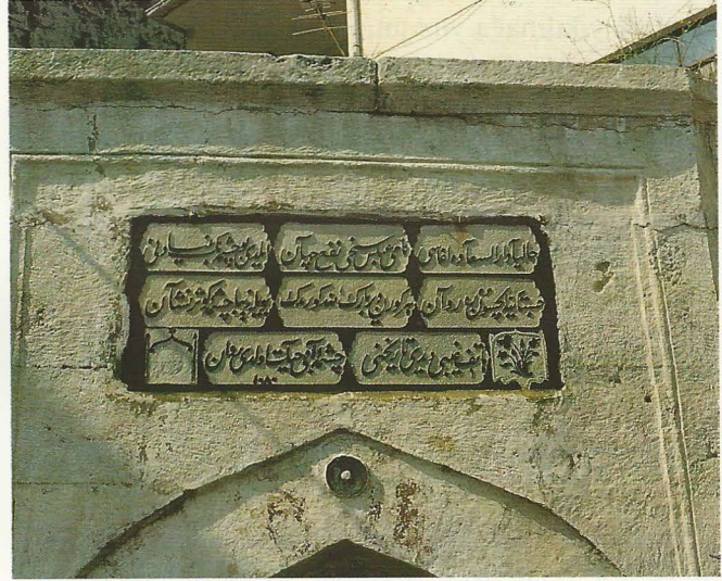
Arakiye Camii karşındaki Abbas Ağa Çeşmesi ve kitabesi
