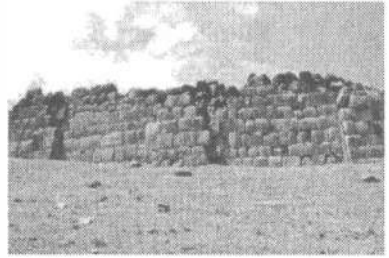
Körzüt kale duvarlarının kalıntıları
