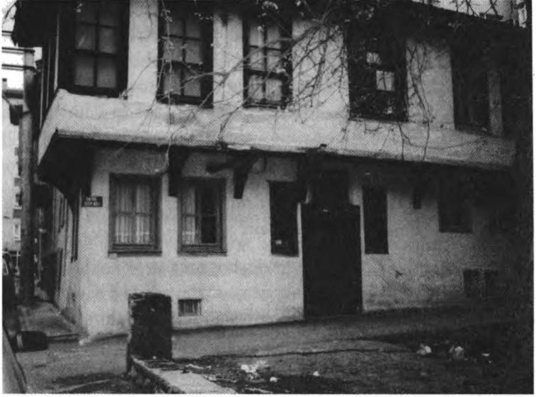
Dere Sokağı'ndaki ev. Bursa, 2000
