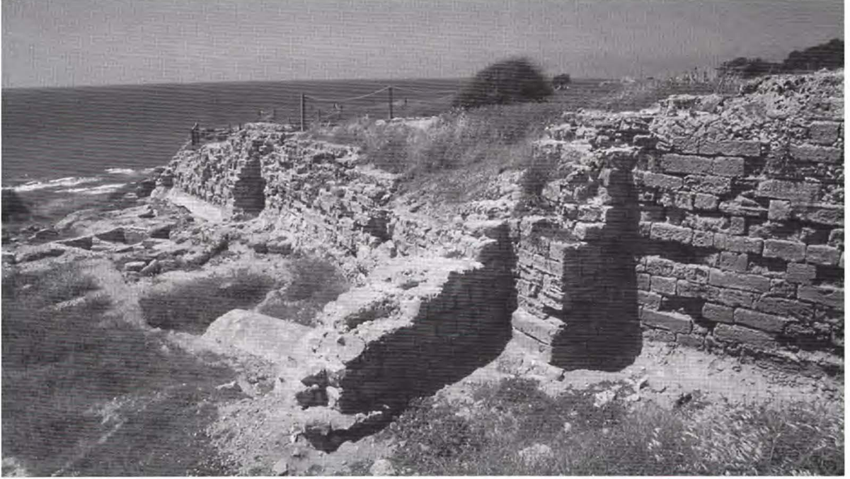
Arsuf'un erken İslâm ve erken Haçlı dönemlerinde inşa edilen surları, şehrin güneybatı ucunda neredeyse hiç değişime uğramadan kalmış (Yazarın çektiği fotoğraf).
