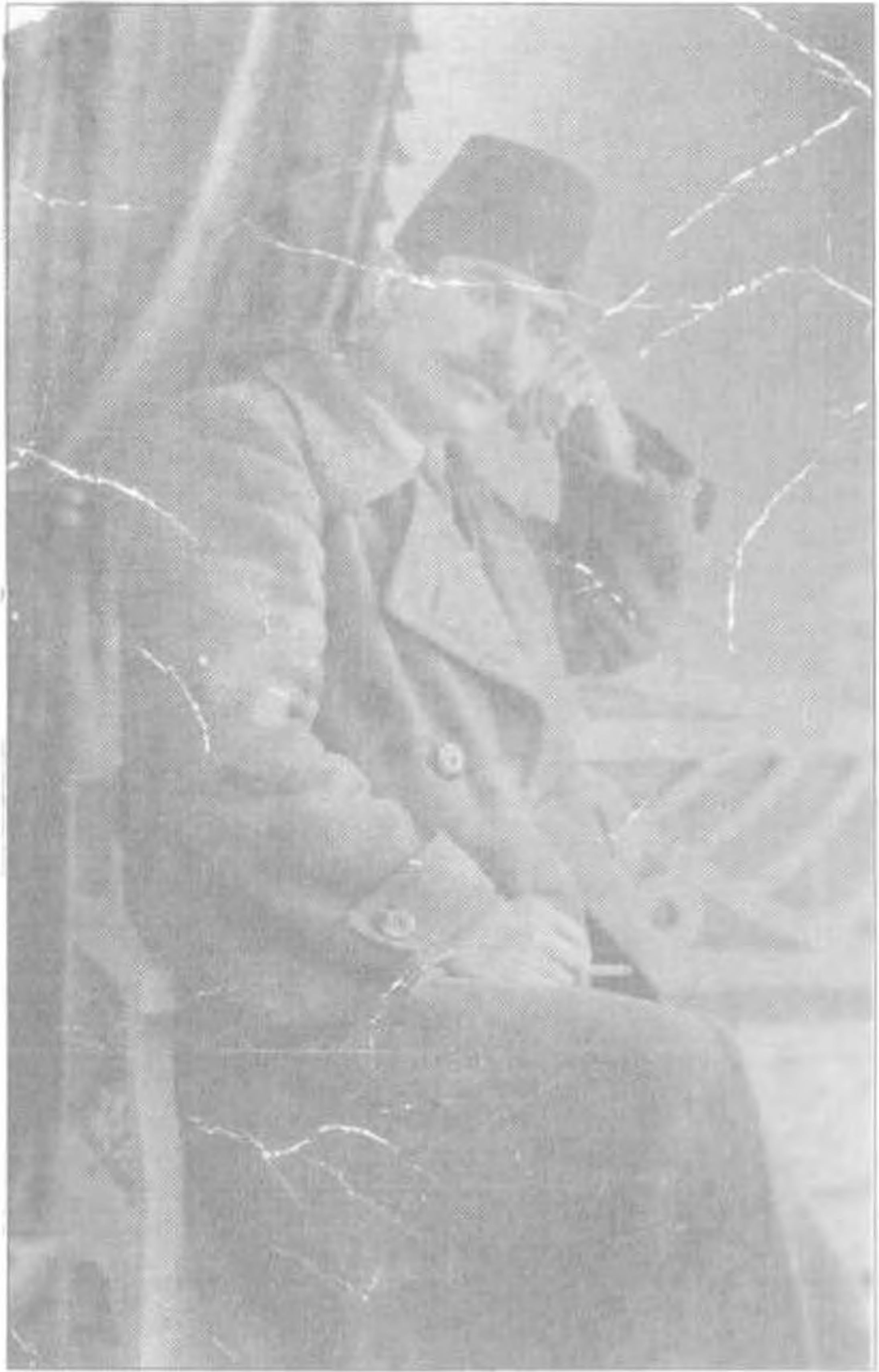
Süleyman Bey'in Bulgaristan'da esir kampında çekilmiş bir fotoğrafı
