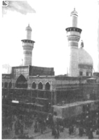
Karbela İmam Abbas Camii
