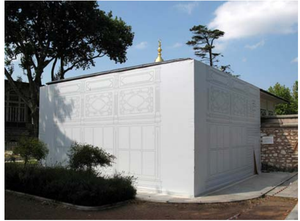
Fotoğraf-9: Topkapı Sarayı Müzesi'nde bulunan Kara Mustafa Paşa Köşkü restorasyon çalışmaları
