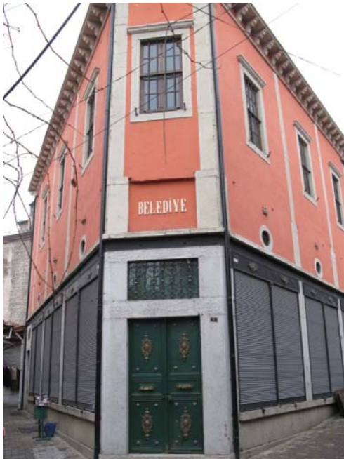
Fotoğraf-13: Restore edilmiş olan eski belediye hizmet binası
