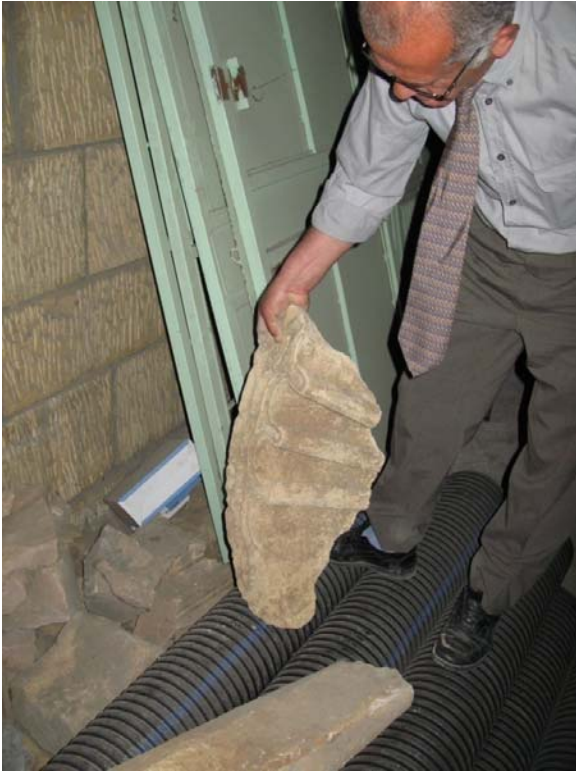
Fotoğraf-10: Deprem sonrası düşen taş parçası
