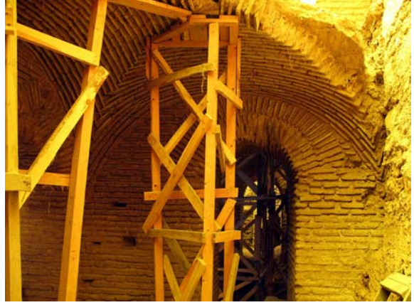
Fotoğraf-7: Four Seasons Oteli'nin bulunduğu parselde yapılan otele ait ek bina inşaatı
