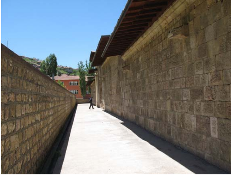
Fotoğraf-15: Doğu cephedeki betonarme platform
