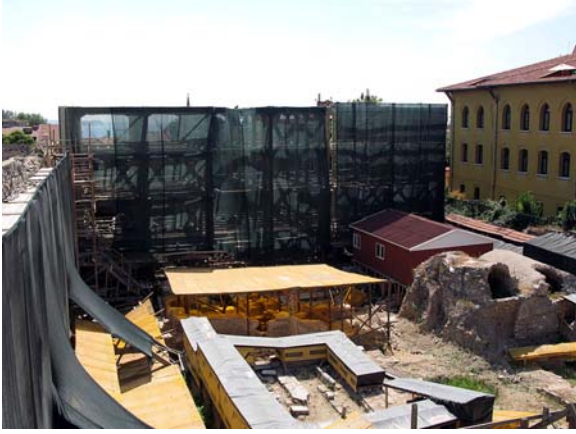
Fotoğraf-6: Four Seasons Oteli'nin bulunduğu parselde yapılan otele ait ek bina inşaatı
