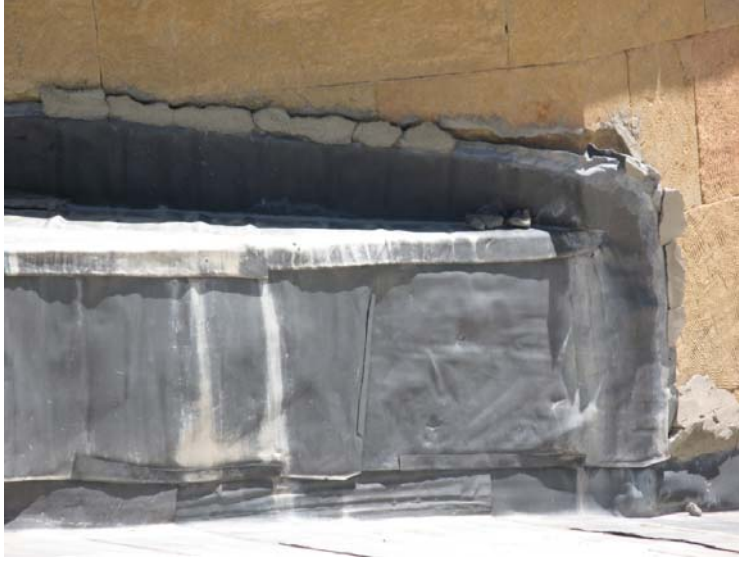
Fotoğraf-13: Örtünün taşla birleşen kesimlerdeki durumu
