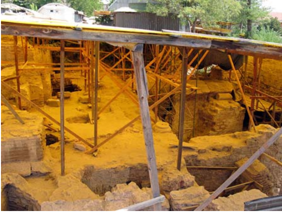
Fotoğraf-8: Four Seasons Oteli'nin bulunduğu parselde yapılan otele ait ek bina inşaatı
