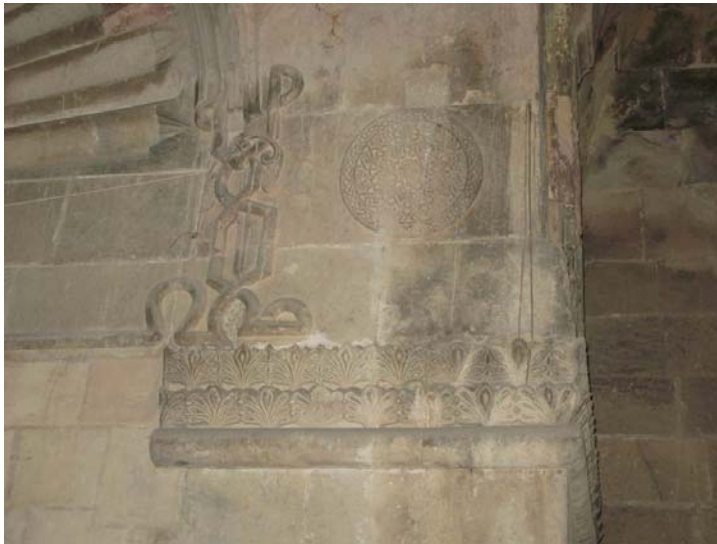
Fotoğraf-14: Yapı içindeki nem ve tuz tahribatı
