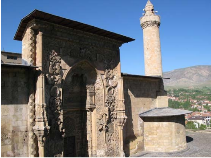
Fotoğraf-4: Kuzey cepheden Ulu Camii minaresinin görünümü
