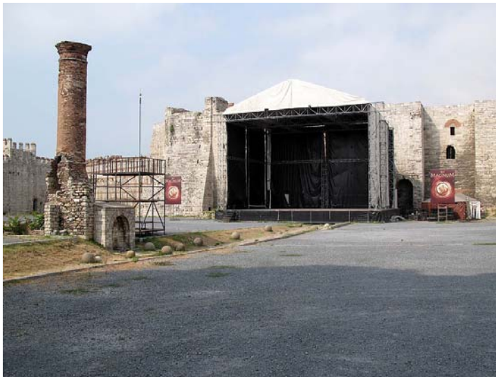
Fotoğraf-14: Yedikule Hisarı'na kurulan platform Altın Kapı'yı engellemektedir
