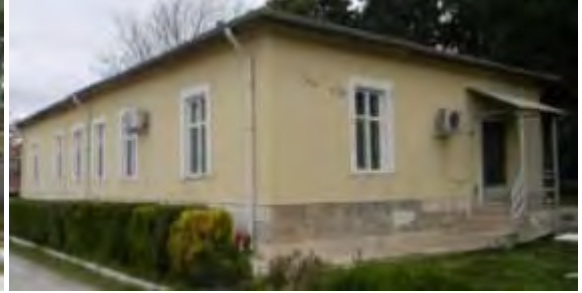
Resim 11. Geçici Konaklama Binası (Özcan, 2019: 51)
