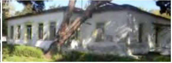
Resim 9. Geçici Konaklama Binası (Özcan, 2019: 51)
