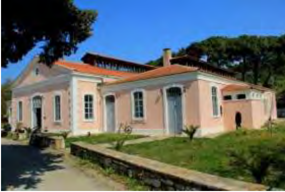
Resim 19. Büyük Tahaffuzhane Binası (Şaşmaz, 2012: 2)
