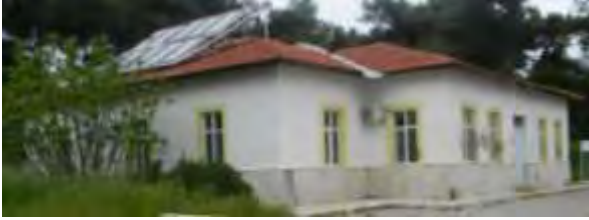
Resim 8. Geçici Konaklama Binası (Özcan, 2019: 63)
