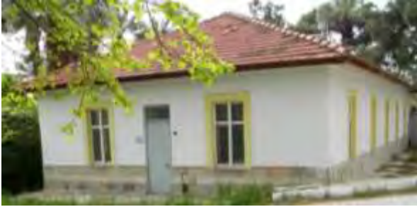
Resim 10. Geçici Konaklama Binası (Özcan, 2019: 54)
