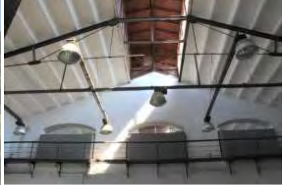
Resim 20. Büyük Tahaffuzhane Binası Çatı Makasları (Şaşmaz, 2012: 6)
