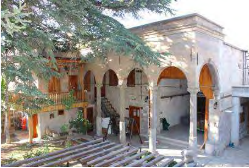
Şekil 11: Evin güney cephesi revak bölümü.
