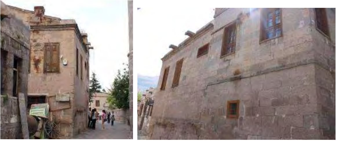
Şekil 5: Soldaki: evin güney (çıkma sokak), sağdaki: doğu cephesi.
