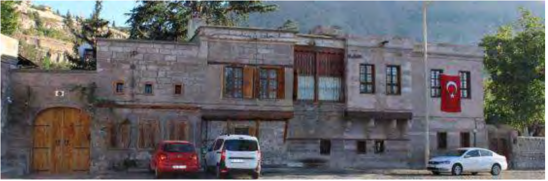
Şekil 10: Evin kuzey cephesi.
