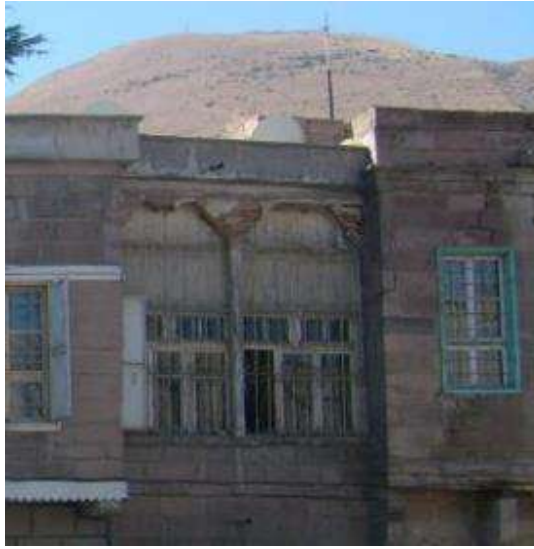
Şekil 13: Restorasyon öncesi hayatın cephe açıklığı.
