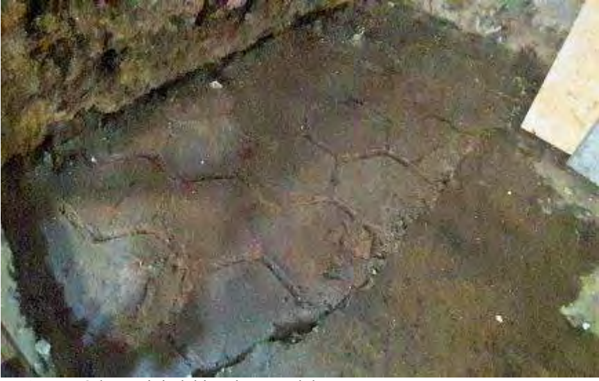
Resim 12. Oda zeminindeki şehane tuğlaları
