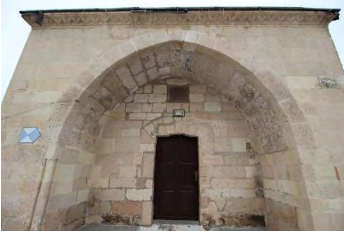
Fotoğraf 14. Kuzey cephe, eyvan şeklinde giriş bölümü
