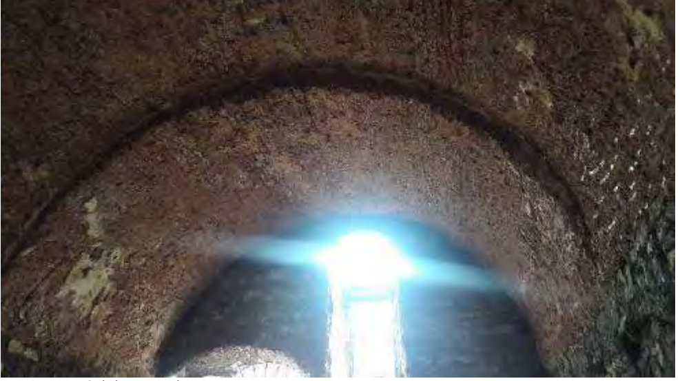
Resim 10. Odaların tuğla tonoz örtüsü
