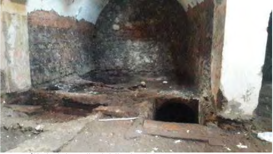
Resim 15. İkinci avluda merdivenle inilen depo bölümü
