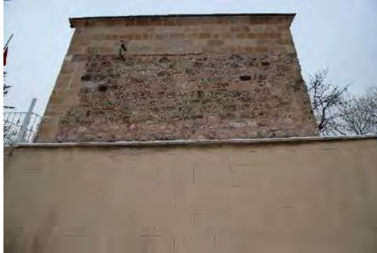
Fotoğraf 12. Batı Cephe
