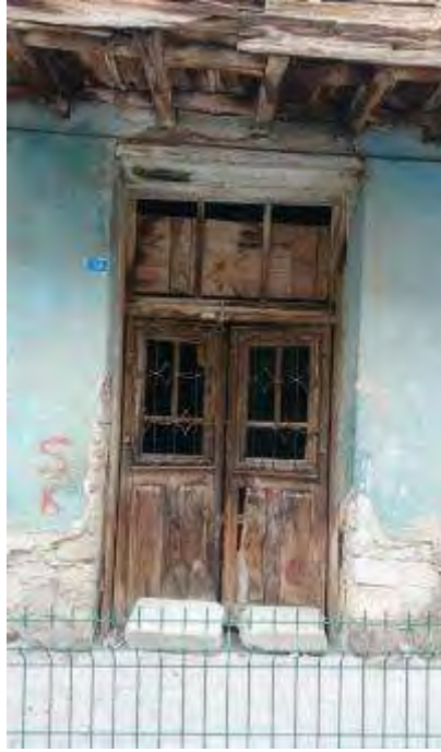
Resim 2.Özdemir Mahallesi Gün Sokak No:18
