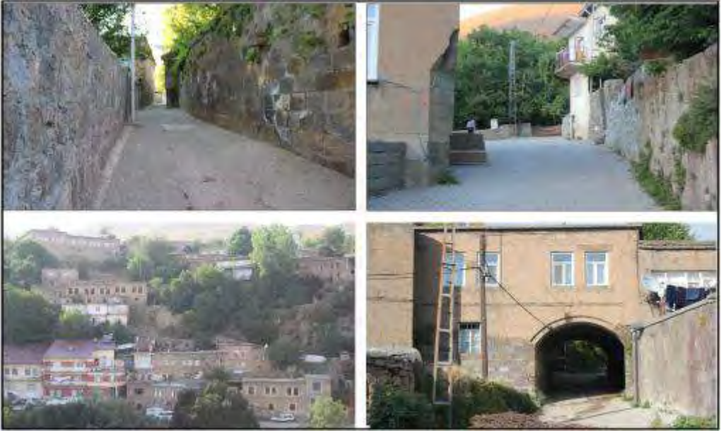
Foto 6. Geleneksel Bitlis Evleri ile Sokak Kalıplarından Görünümler
