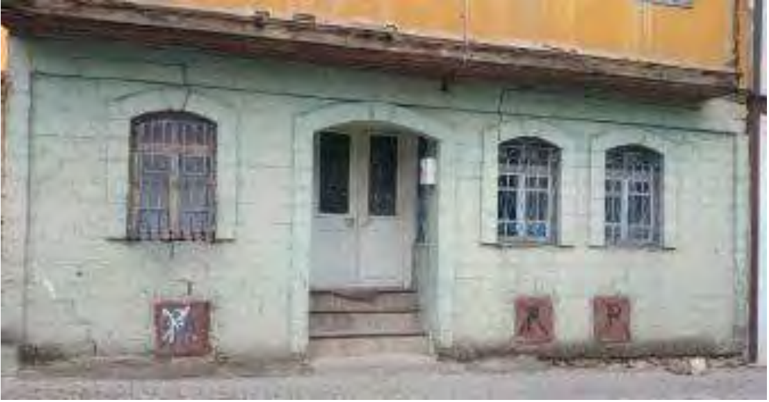
Resim 18. Özdemir Mahallesi Gün Sokak No:11
