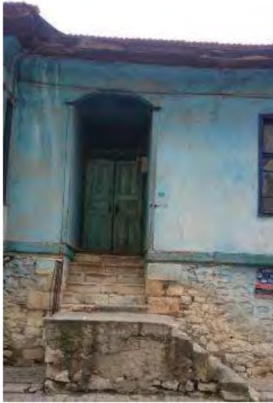
Resim 15. Özdemir Mahallesi Gün Sokak No:2
