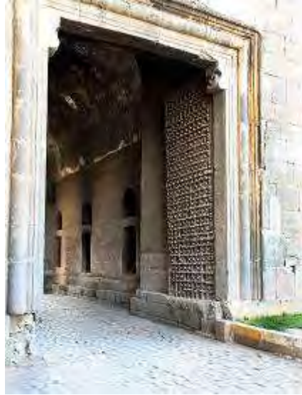
Resim 3: Artuklu Dönemi Kuzey Kapı-geçiş mekânı
