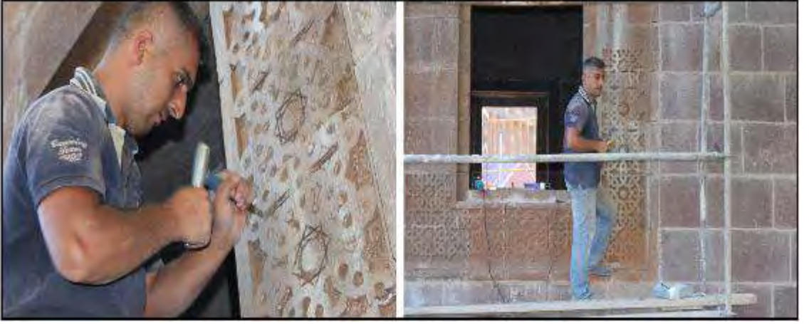
Foto 5. Hakan Usta İhlasiye Medresesi'ndeki Çalışmalarına Devam Etmektedir.
