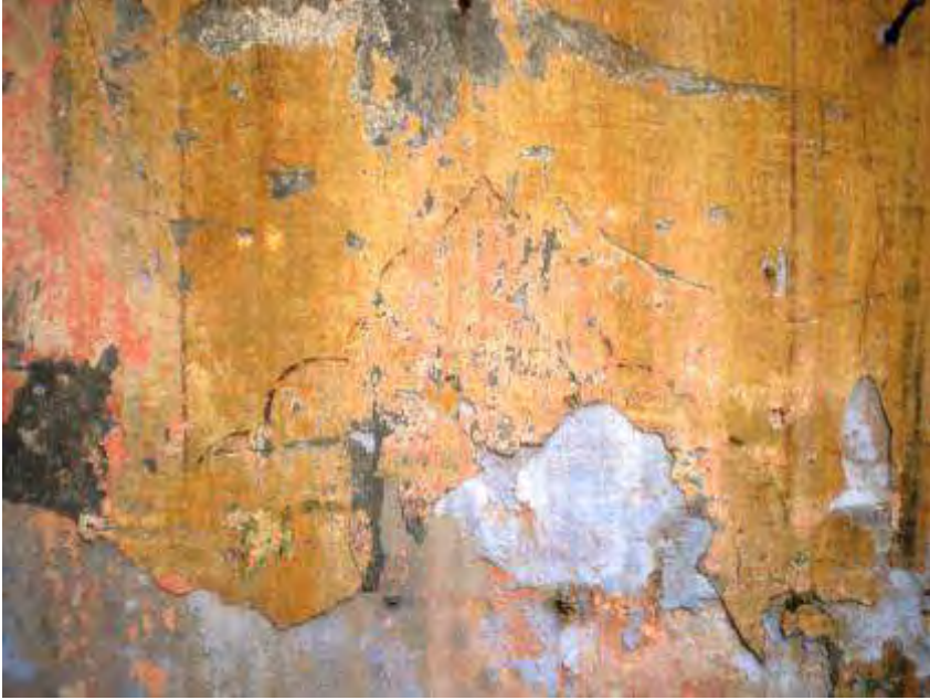
Resim 16. Z05 nolu mekanda görülen kalem işi bezemeye ait izlerden detay (S.Parlak, 2012)
