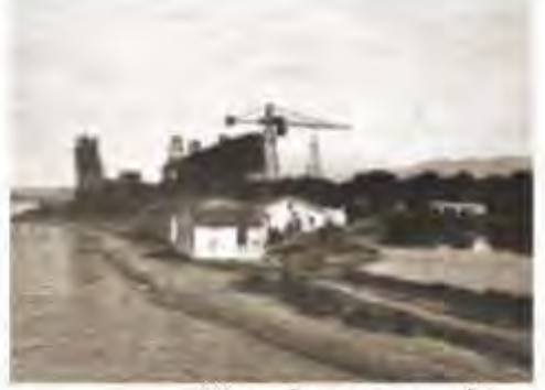
Havuz inşa aşamasında
