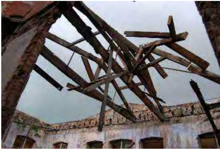
Resim 20. Binanın çökmüş olan üst örtüsü (S.Parlak, 2012)
