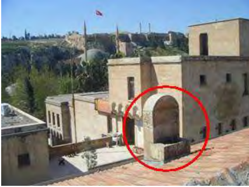
Fotoğraf 1: Eyvanın Damında Yer alan Rüzgar Sirkülasyon Bacası.
