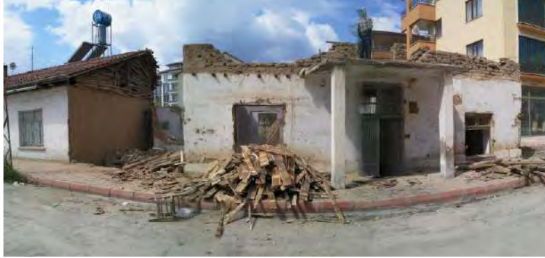
Foto-2: Yıkılmakta Olan Eski Bir Malatya Evi (Kerpiç ve Ahşaptan İnşa Edilmiş)
