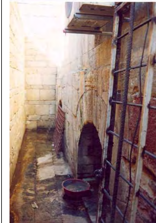
Fotoğraf 12 Bakü Aşur Mescidi güneydoğu cephe altkati
