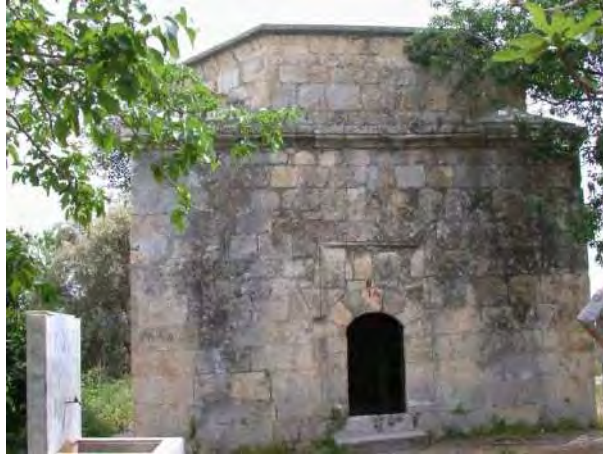
Fotoğraf 13- Camili (Gökçeli) Köyü Türbesi, kuzey cephesi.
