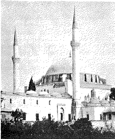
Sultan Selim Camii (Yapılışı 1522)
