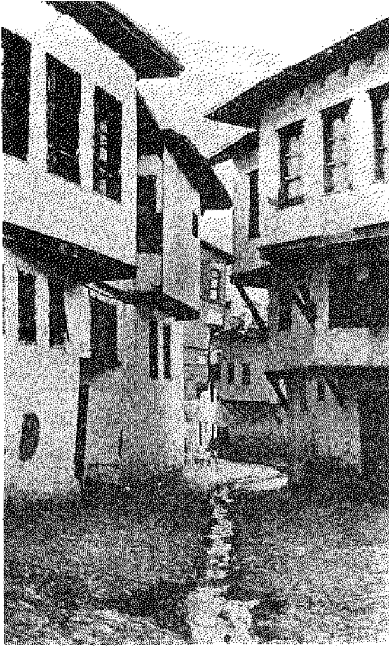
Kütahya'da Pirlar Mahallesindeki eski evler
