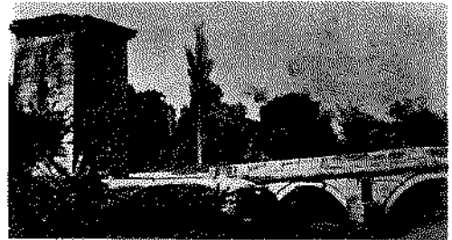
Edirne - Sarayıcı yolunda Sarayıcı Köprüsü ve Fatih'in Adalet Kasrı. Köprü üç gözlüdür, 58 metre uzunluğundadır
