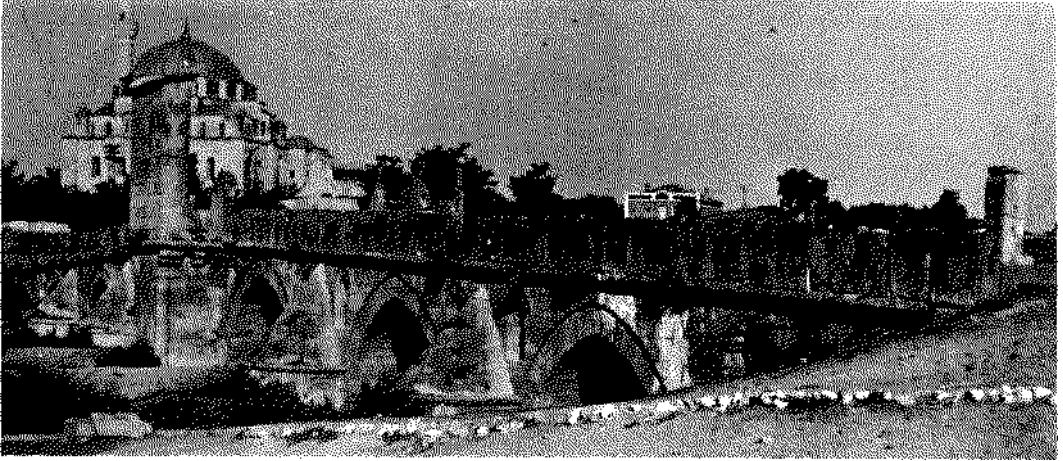
Istanbul — Edirne yolunda 1627 yılında Mimar Davut tarafından yapılmış olan Babaeski Köprüsü. 72 metre uzunluğundadır, altı gözlüdür. En büyük göz açıklığı 11 metre 40 santimdir.
