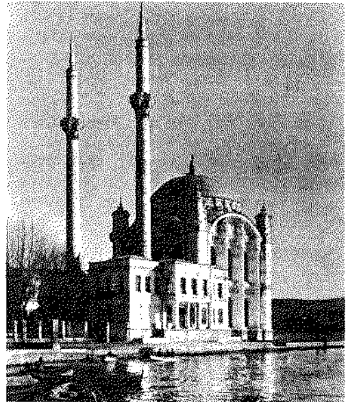
Barok ve empir karışımı bir üslûpla yapılan Ortaköy Camii
