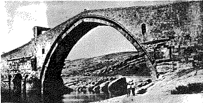
Selçuklular tarafından Diyarbakır — Silvan yolunda yapılmış olan Malabadi köprüsü. 80 metre uzunluğundadır. En büyük göz açıklığı 38 metre 60 santimdir.
