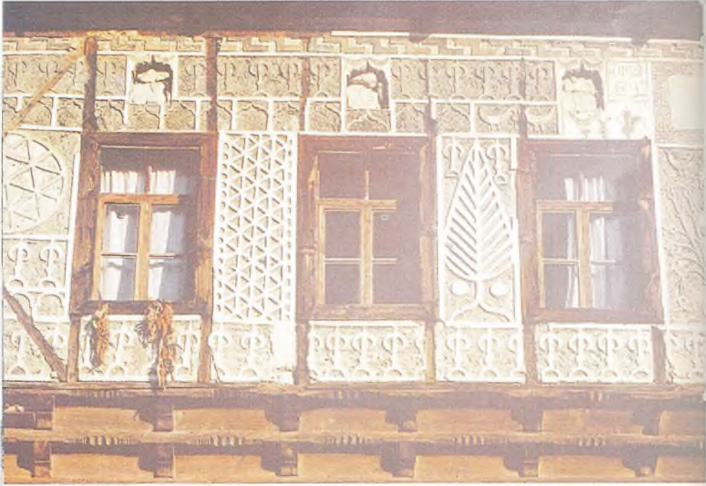
Safranbolu, alçı cephe bezemeleri
