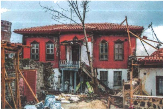
HAMAMÖNÜ VE HACIBAYRAM ÇEVRESİNDE YENİLENEN VE KİMLİĞİNİ KAYBEDEN YAPILAR İLE HALA BAKIM VE ONARIM GEREKTİREN YAPILAR (Fotoğraflar: Taşkın, M.)
