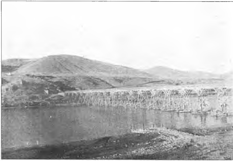
Pertek önünde Murat suyu ve tahta Pertek köprüsü.
