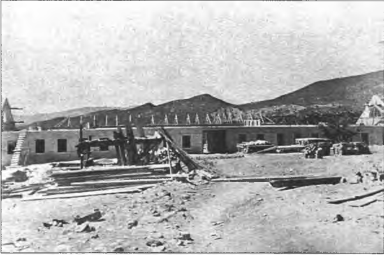
Mameki'de devlet binaları inşaatı.
