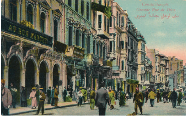
Solda Bon Marché, Grande Rue de Pera
