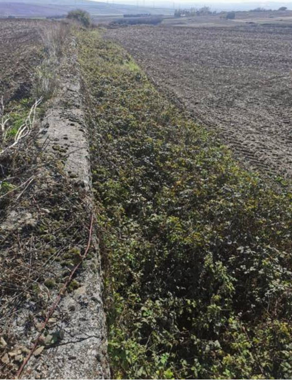
Nakkaş ile Yassıören köyleri arasında kalan bölgede betonla desteklenmiş bir hendek
