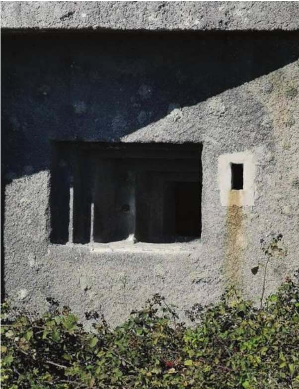
Koruganların atış noktaları için hazırlanmış noktalar çelik pencerelerle kapanabilmekteydi
