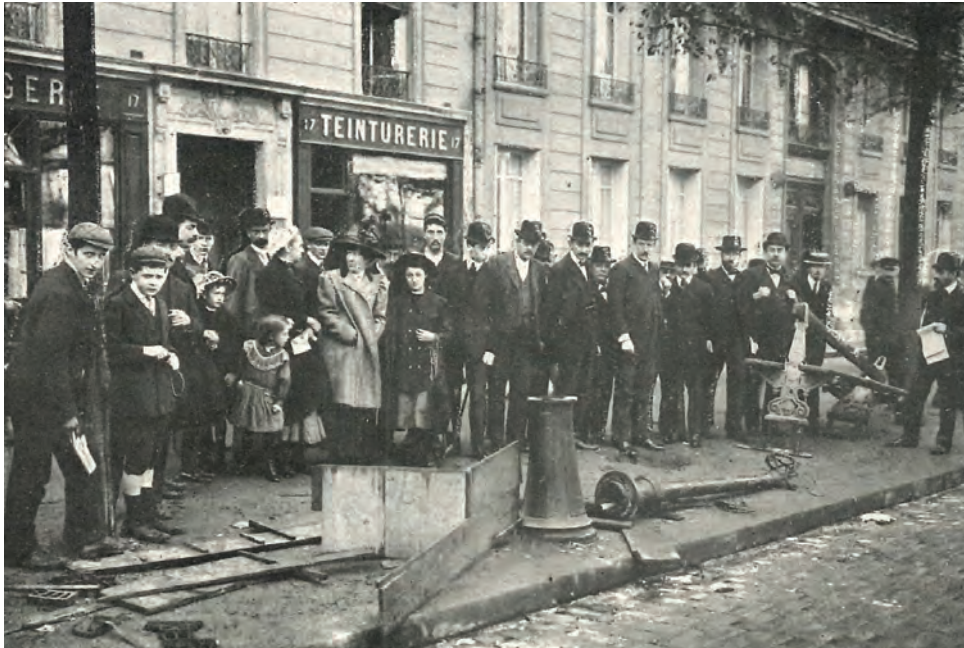
Ferrer'in idamı aleyhine Paris'te İspanya sefarethanesi civarında icra edilen nümayişler esnasında ika olunan tahribat. Resimli Kitap No: 14
