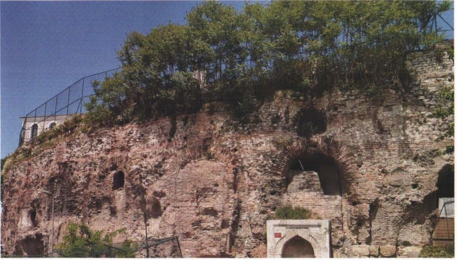
Sphendone yapısının Nakilbent Sokak'tan görünümü
