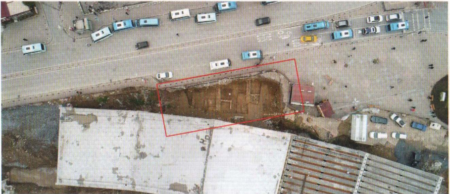
P3 viyadük ayağı kazı alanı
