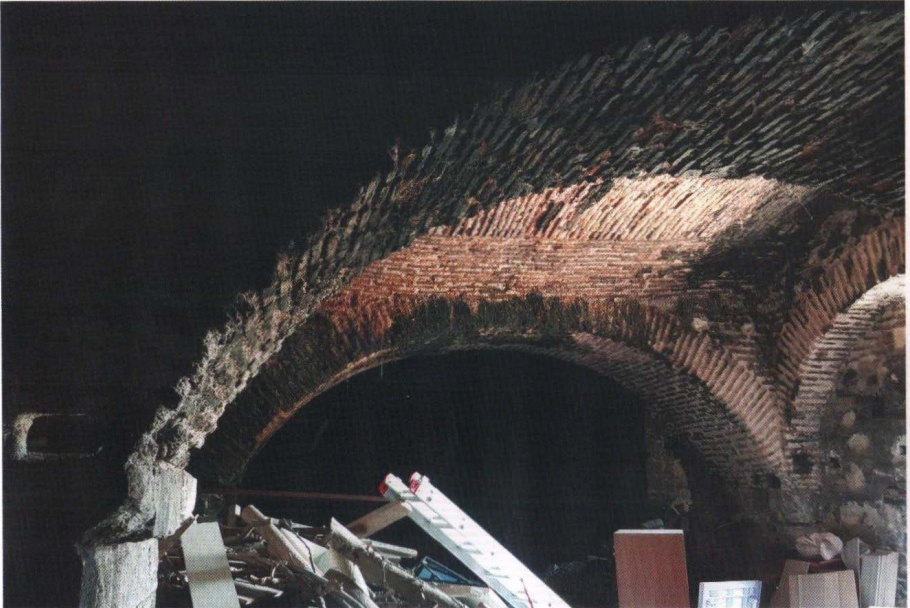
Torun Sokak'taki altyapıdan görünüm
