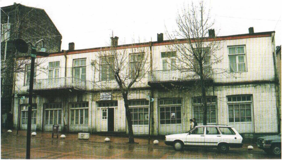
Millî Şura'nın 1918'de ilk toplantısı yapıldığı bina (1996); 2006 yılında yerinde otel yapmak üzere yıkılır
