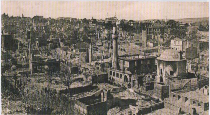
Le grand Incendie de Stamboul du 25. Août 1908
