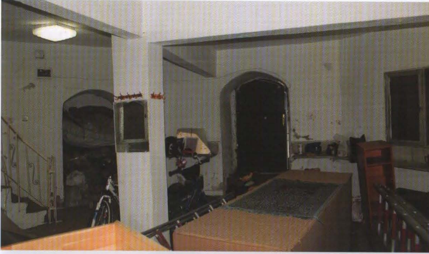
Sunullah Efendi Türbesi, zemin kat sanduka, muhdes betonarme döşeme, kolon ve merdiven.
