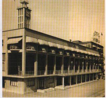
Merkez Han ile Çini Han arasında inşa edilen ve 2 Temmuz 1940'ta açılışı yapılan, üst katında Liman lokantasının bulunduğu yolcu salonu binası.
