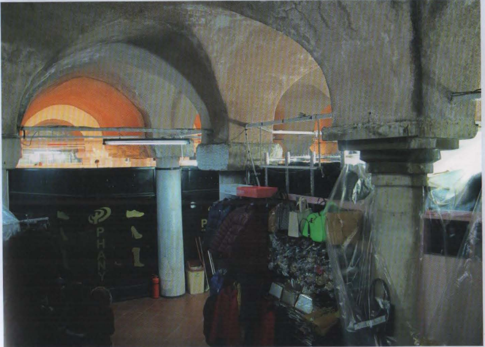
Resim 10 Myrelaion Sarnıcı, taşıyıcılar arasına yerleştirilmiş bölmeler ile algılanabilirliğin yitirilmesi.
