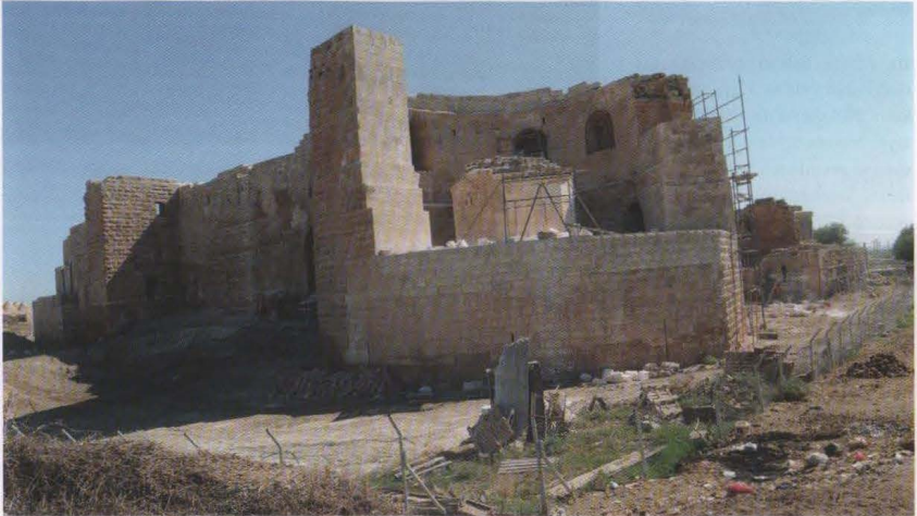
Resim 10 Harran Kalesi kalıntıları.
