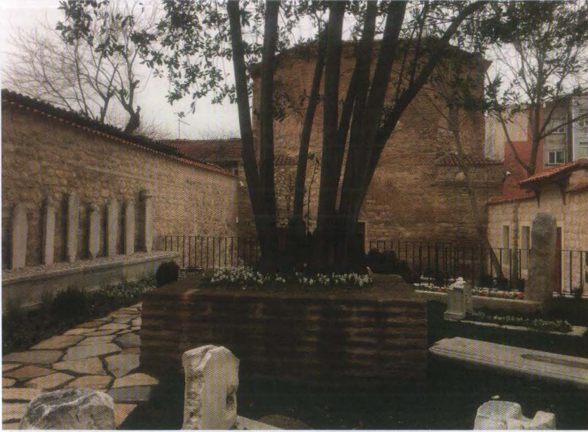
Mescidin haziresinden restorasyon sonrası görünüm.
